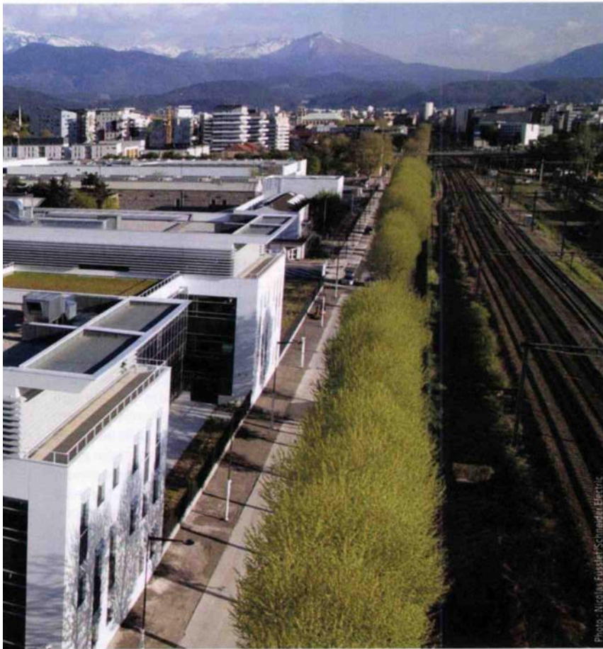
← Le siège de Schneider Electric, projet pilote d'optimisation de l'efficacité énergétique à l'aide de la solution EcoStruxure.
